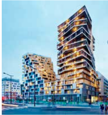
HOME , 96 logements en accession + 92 logements sociaux + commerces, ZAC Masséna, Paris XIII Bouygues Immobilier Surface : 13 750m 2 Livré : 2015
