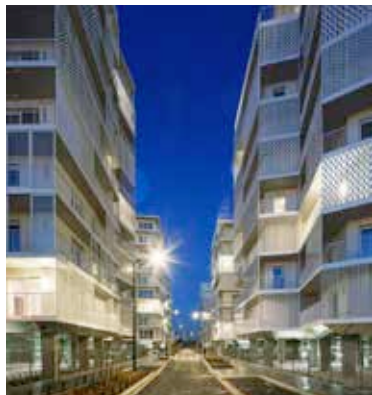
Rue Camille Claudel , 330 logements + crèche, ZAC du Bac d'Asnières, Clichy-la-Garenne (93) SOGEPROM Surface : 24 000m 2 Livré : 2017
